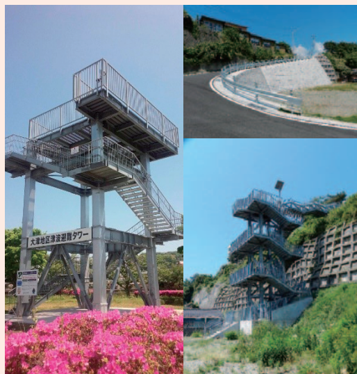
写真左／大津地区津波避難タワー（北茨城市大津町） 写真右上／退避路（日立市旭町） 写真右下／津波避難階段（日立市旭町）
