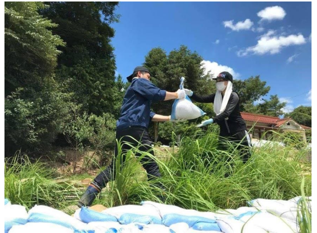
土砂撤去作業の様子（左：浅野議員）
